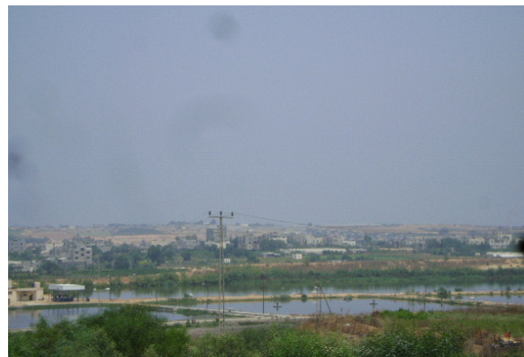
Beit Lahia Wastewater Treatment Plant
